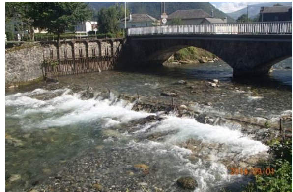
Vue depuis l'aval
